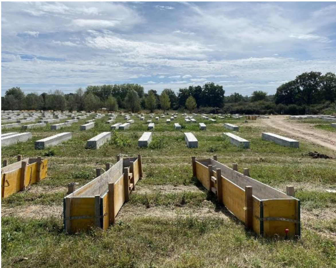
Coffrage pour fondations sur longrines béton – parc des grandes jonchères (Vierzon, 18)
