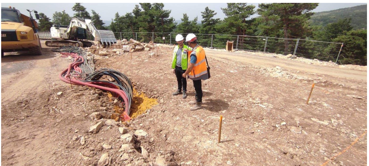
Délimitation (piquets en bois) du futur poste de livraison – centrale solaire des Omergues (04)
