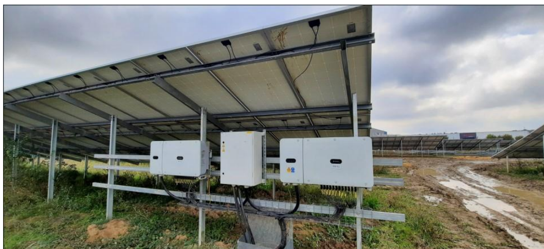
Vue des onduleurs et de la connectique entre les modules solaires (fondations sur pieux battus) – parc solaire du vieux domaine à Vierzon (18)
