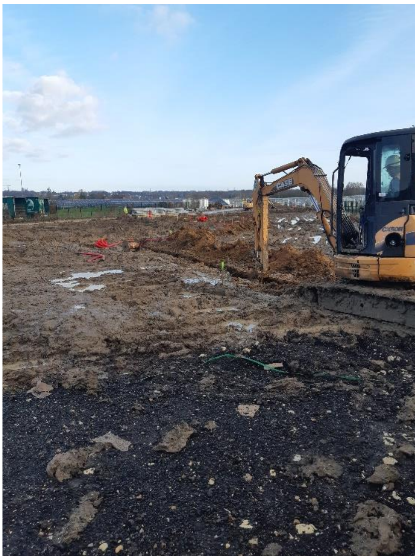
Creusement d'une tranchée sur la centrale solaire du Vieux Domaine (Vierzon, 18)
